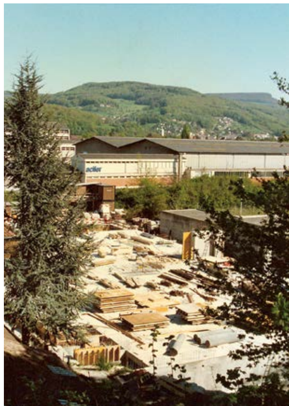
Baustelle an der Reinacherstrasse in Münchenstein
