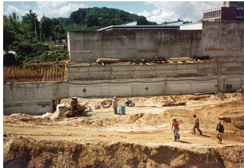
Erste Arbeiten auf der Baustelle
